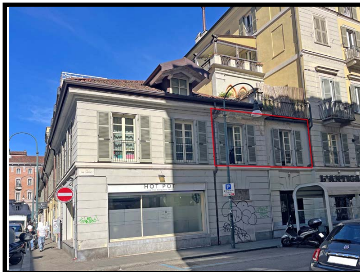
Fotografia ripresa dal CTU del fronte lato Via SAN QUINTINO con indicazione (rettangolo rosso) dell'immobile oggetto della presente procedura
